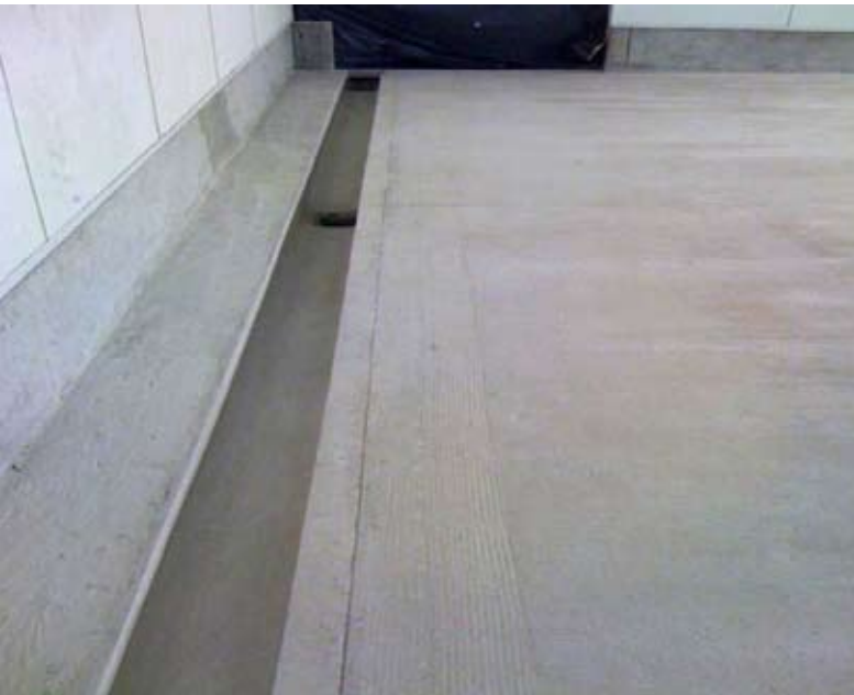
Arriba: Aplicación de imprimación en zócalos.
