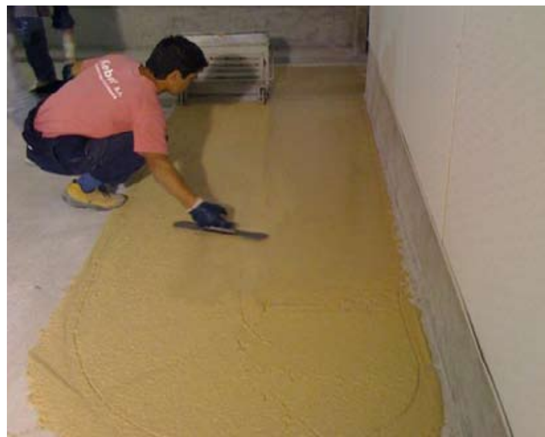
Arriba: Extendido del producto con Screen Box. Abajo: Alisado de la superficie.
