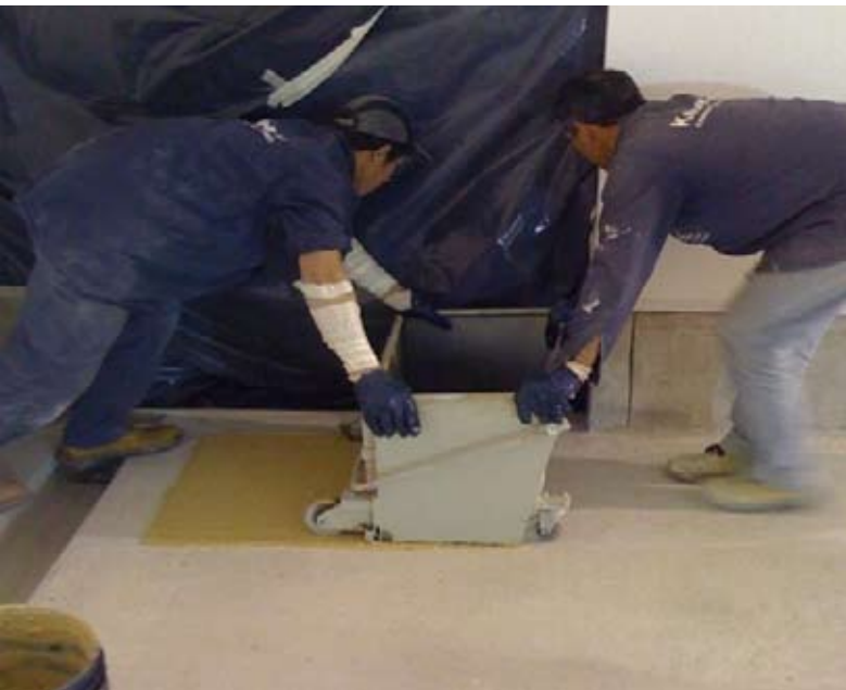
Arriba: Mezclado de los tres componentes Abajo: Extendido del producto con Screen Box.
