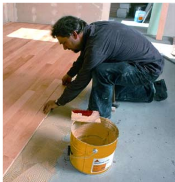
arriba: SikaBond® T53 pegado mediante cordones. abajo: SikaBond® T55 pegado en superficie completa.
