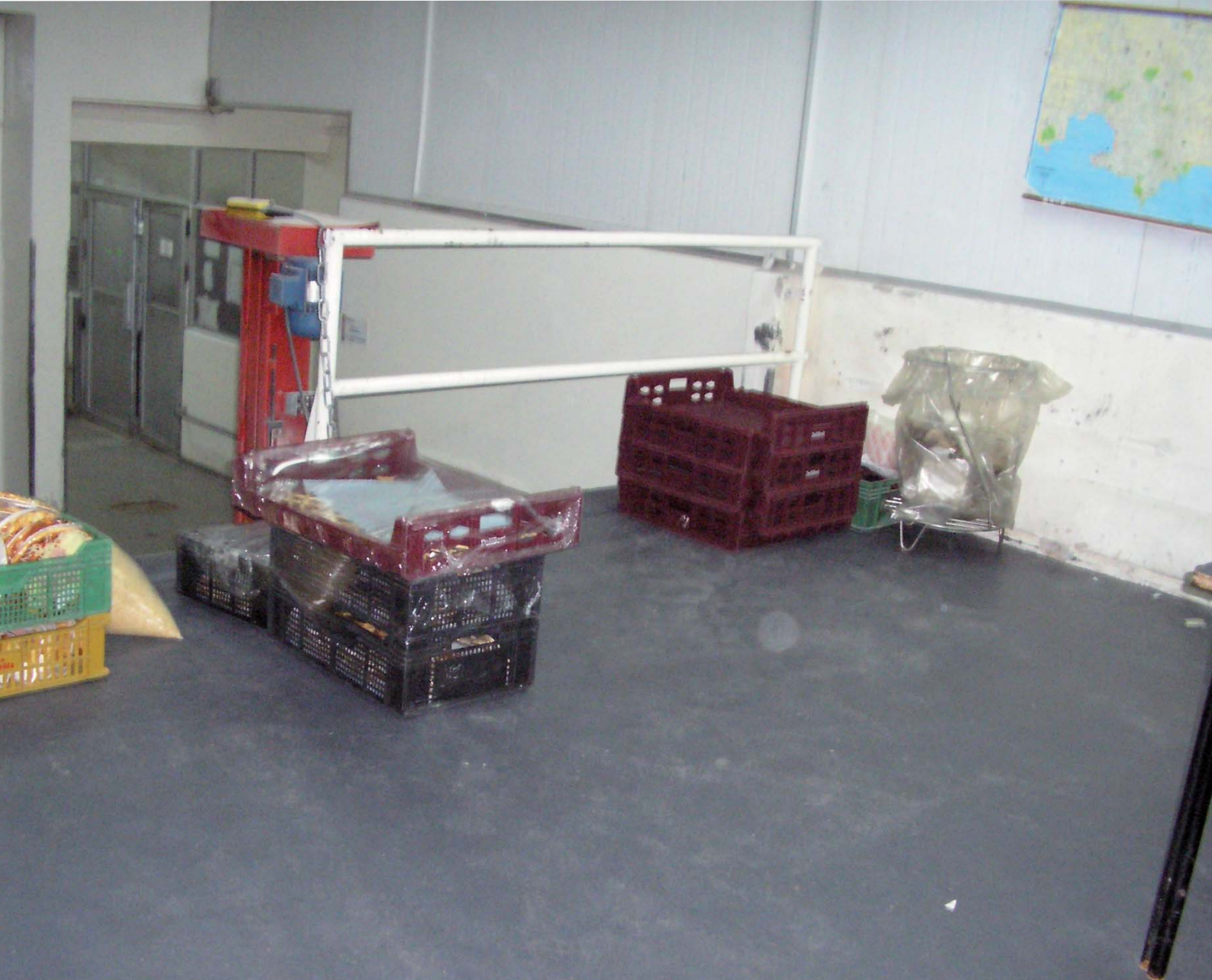
Area "Expedición" (70m 2 ) con Sikafloor 19 N Purcem gris aplicado y en uso.
