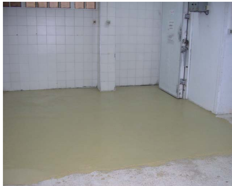
Arriba: Rodillado en area "Tortas" (200m 2 ). Abajo: Área "Envasado" (150m 2 ) con Sikafloor 19 N Purcem beige aplicado.
