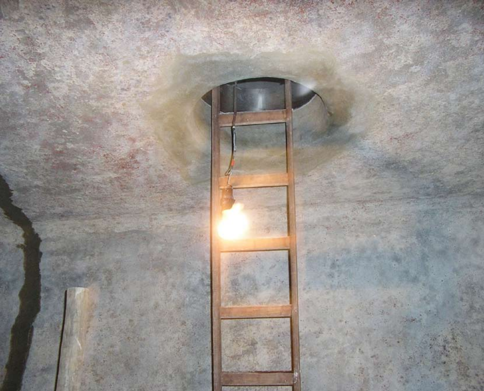
Vista interior de cuba vinaria.
