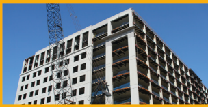
REPARACIÓN DE CONCRETO
