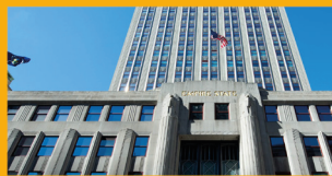
REPARACIÓN Y PROTECCIÓN
