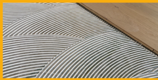
INSTALACIÓN DE PISOS
