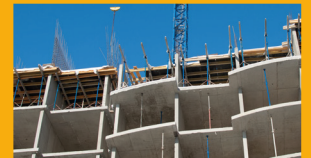
FUNDICIÓN IN-SITU Y PREFABRICADOS DE CONCRETO
