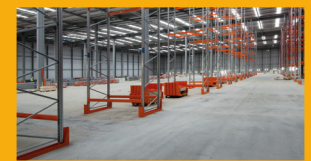
LOSAS DE CONCRETO
